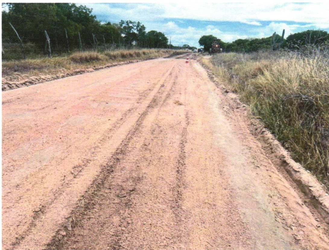
Foto 09 - EXECUÇÃO E COMPACTAÇÃO DE ATERRO COM SOLO PREDOMINANTEMENTE ARGILOSO - EXCLUSIVE SOLO, ESCAVAÇÃO, CARGA E TRANSPORTE. AF_11/2019
