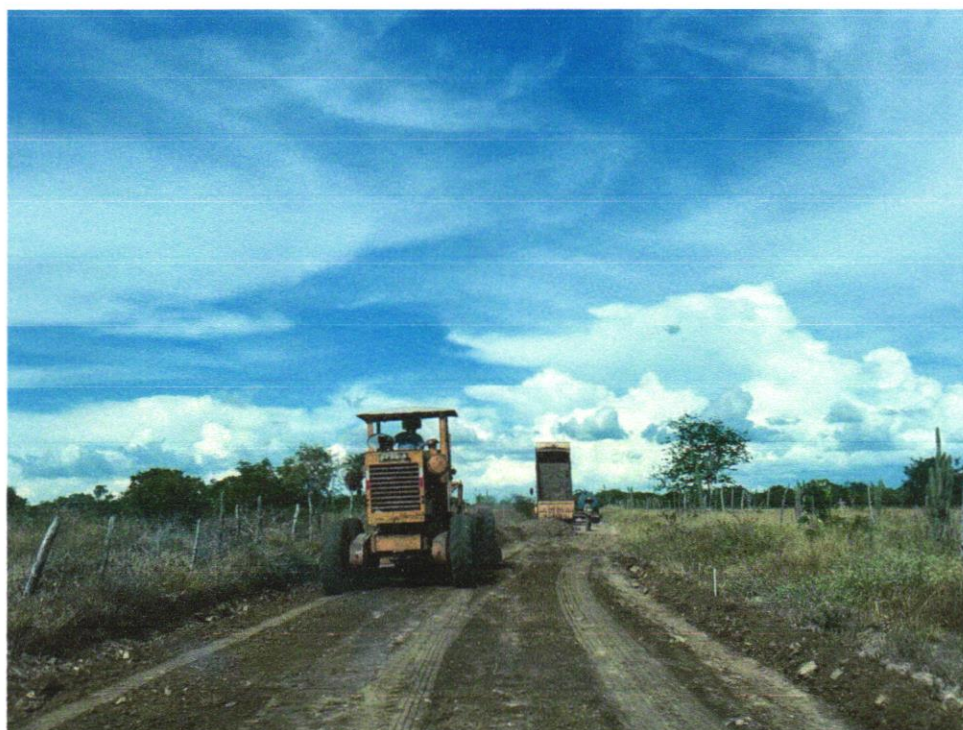
Foto 05- ESPALHAMENTO DE MATERIAL COM TRATOR DE ESTEIRAS. AF_11/2019
