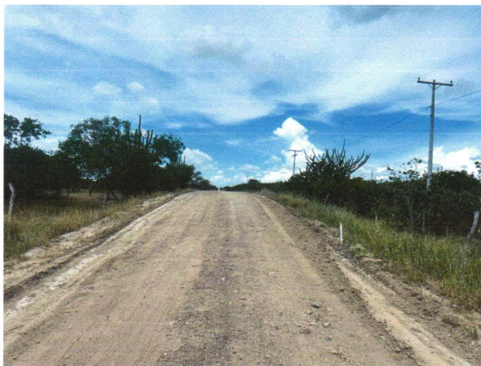
FOTO 01 – REGULARIZAÇÃO DE SUPERFÍCIES COM MOTONIVELADORA. AF_11/2019
