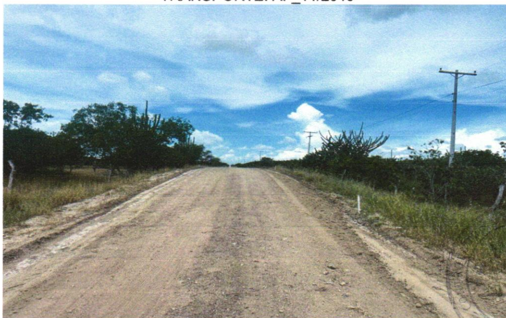
Foto 10 - EXECUÇÃO E COMPACTAÇÃO DE ATERRO COM SOLO PREDOMINANTEMENTE ARGILOSO - EXCLUSIVE SOLO, ESCAVAÇÃO, CARGA E TRANSPORTE. AF_11/2019
