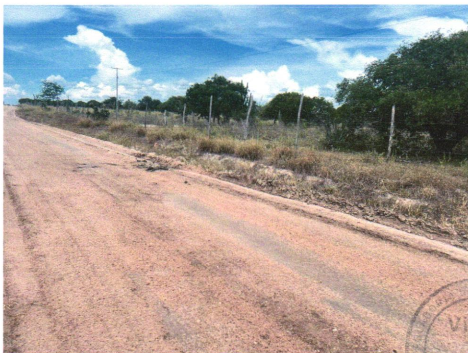
Foto 06- EXECUÇÃO E COMPACTAÇÃO DE ATERRO COM SOLO PREDOMINANTEMENTE ARGILOSO - EXCLUSIVE SOLO, ESCAVAÇÃO, CARGA E TRANSPORTE. AF_11/2019
